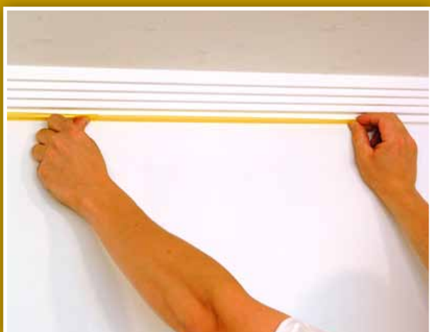
1 MASQUER AVANT D'APPLIQUER LE SABLE PRIMER
