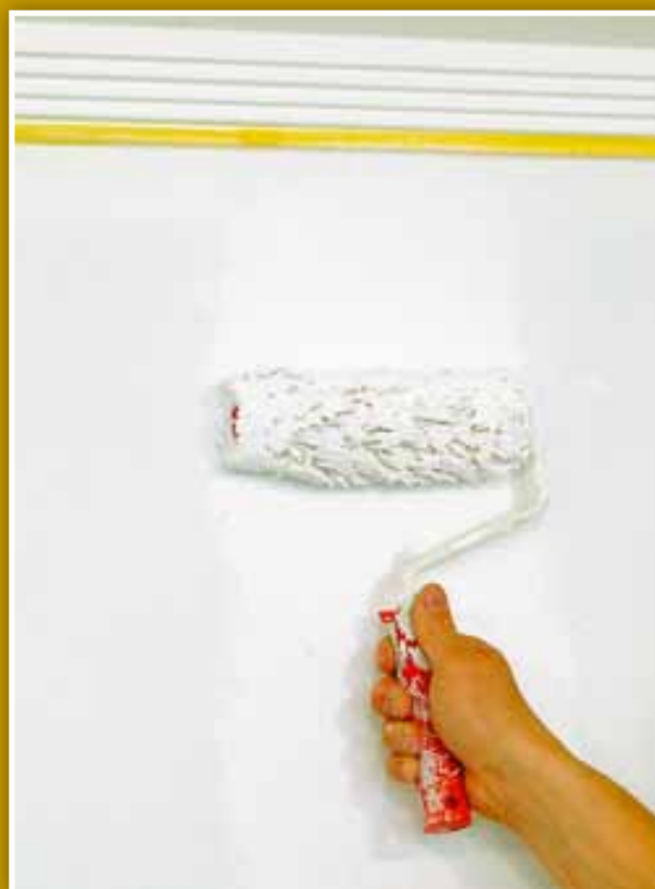
3 APPLIQUER LE SABLE PRIMER AVEC UN ROULEAU DE PEINTURE
